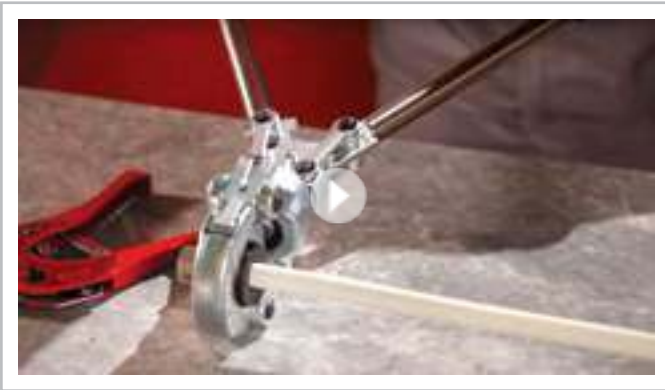
Монтаж металлопластиковых труб.
